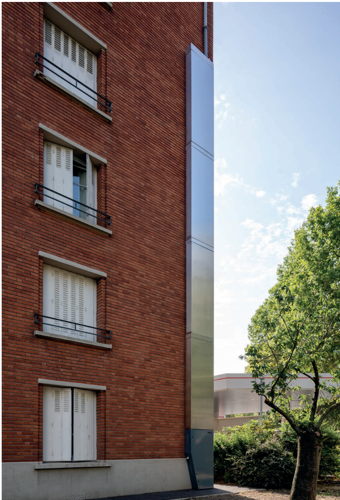
Réservoir de façade, Paris 10 ©Pierre l'Excellent
